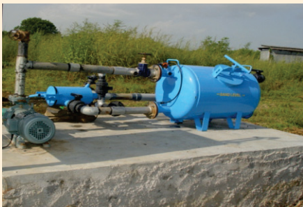
चित्र : सूक्ष्म सिंचाई संयंत्र में उपयोग सैंड फिल्टर टंकी और स्क्रीन फिल्टर
